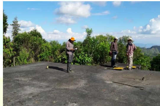
Tanque de Almacenamiento
