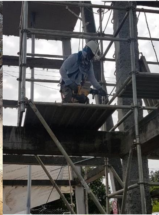
PROCESO DE PREPARACION DE LAS COLUMNAS PARA SU REFORZAMIENTO
