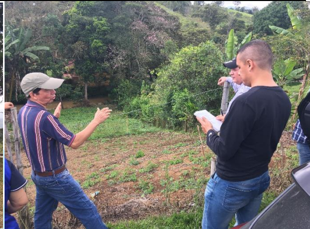
LOTE PARA LA CONTRUCION DE ESTACION DE BOMBEO
