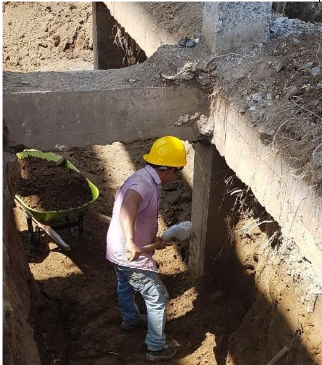
EXCAVACION DE LA CIMENTACION DE LA ESTRUCTURA EXISTENTE, PARA PROCEDER A INTERVENIRLA
