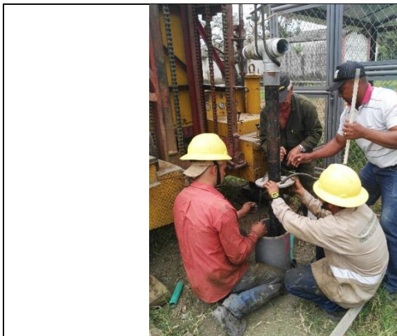
Prueba de Bombeo Pozo VSP-176
